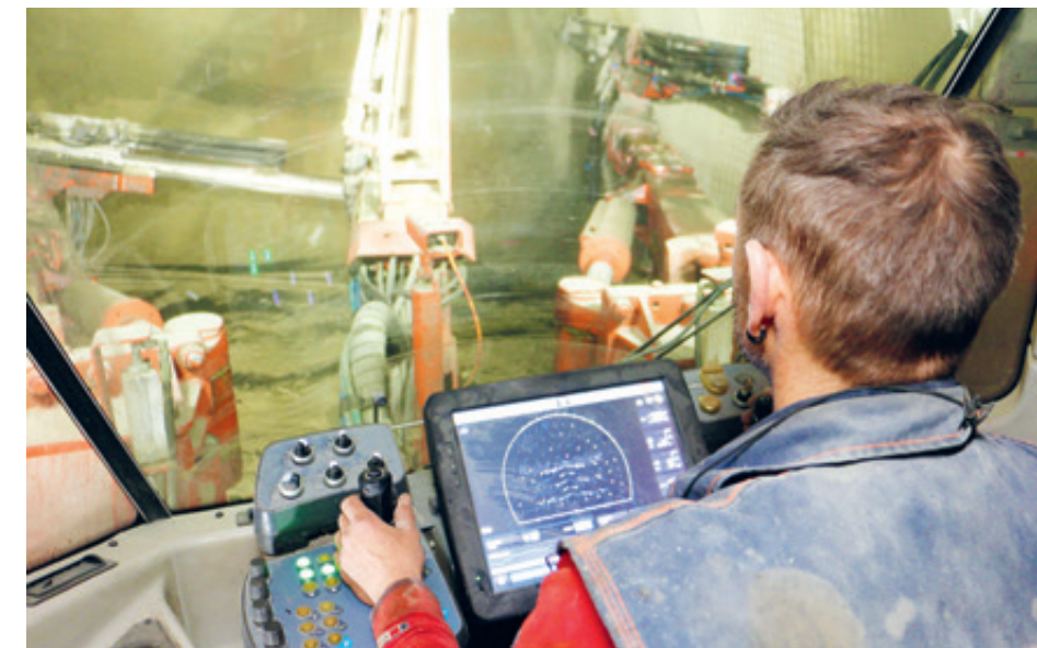
Das Abschlagsprofil wird mit Hilfe der Sandvik Software iSure von den Bauleitern der ARGE H41 entwickelt und auf die Maschine aufgespielt. Die neue Kabine des DT923i bietet einen optimierten Sichtwinkel.
