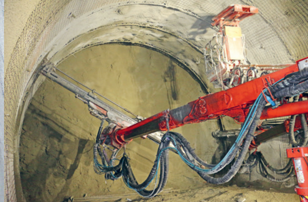
Der Sandvik DT923i ist ein Tunnel-Bohrwagen der neuesten Generation. Er wurde von der ausführenden ARGE speziell für das Baulos H41 Sillschlucht-Pfons angeschafft und ist der erste DT923i in Mitteleuropa.
