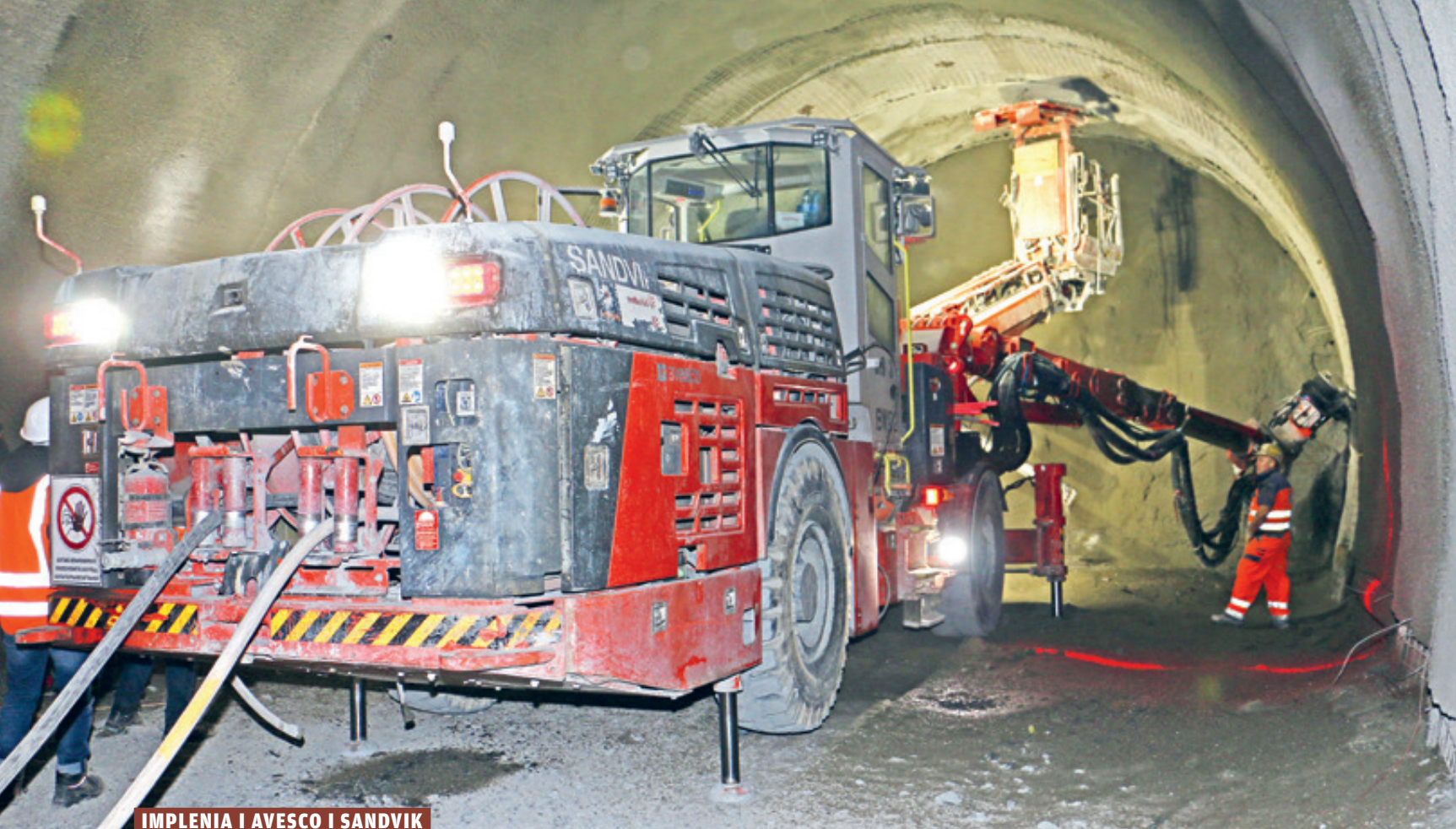
Der Sandvik DT923i ist ein Tunnel-Bohrwagen der neuesten Generation. Er wurde von der ausführenden ARGE speziell für das Baulos H41 Sillschlucht-Pfons angeschafft und ist der erste DT923i in Mitteleuropa.
